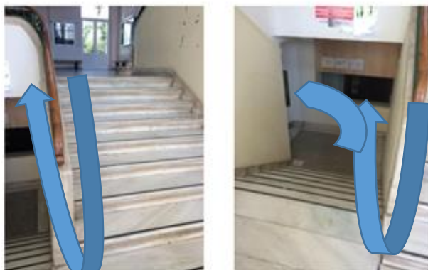
Φωτογραφία 1α: Άποψη της κλίμακας η οποία οδηγεί από τον πρώτο όροφο του Κεντρικού Κτιρίου στο υπόγειο αυτού.
