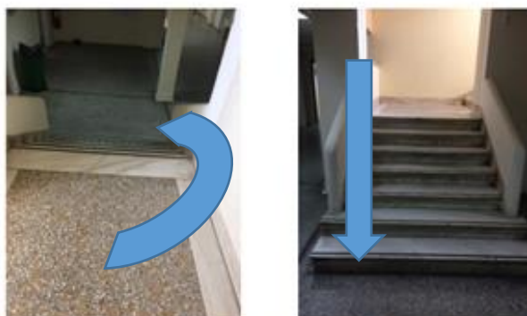
Φωτογραφία 1β: Απόληξη της κλίμακας που οδηγεί στο υπόγειο του Κεντρικού από το ισόγειο αυτού. Άποψη του υπογείου του Κεντρικού Κτιρίου πλησίον του χώρου
