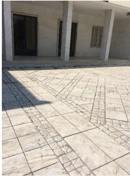
Φωτογραφία 2: Άποψη της κεντρικής εισόδου του Κεντρικού Κτιρίου του Γ.Π.Α.
